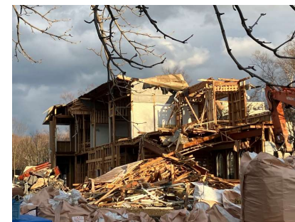
解体中の湯富イン
